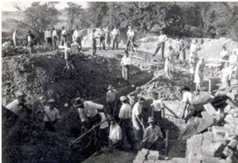
Mještani Marinog Sela u izgradnji svoje škole
