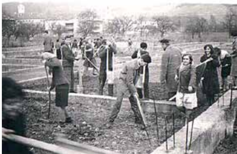
Učenici u izgradnji nove škole u Pakracu
